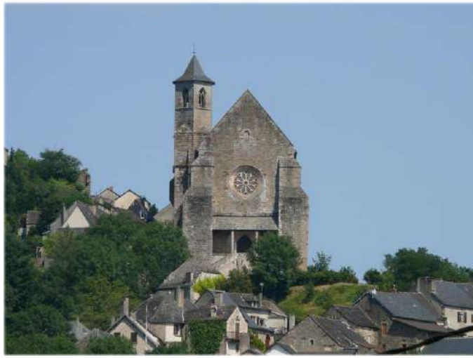
Site structurae-photo Jacques Mossot 07/2007.
