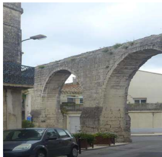
Aqueduc. Photo C. Loupias.
