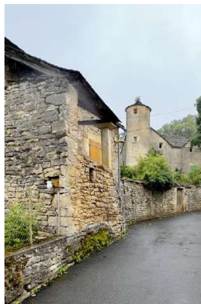
3 – Maison « Paysanne » et tour d'escalier engagée.
